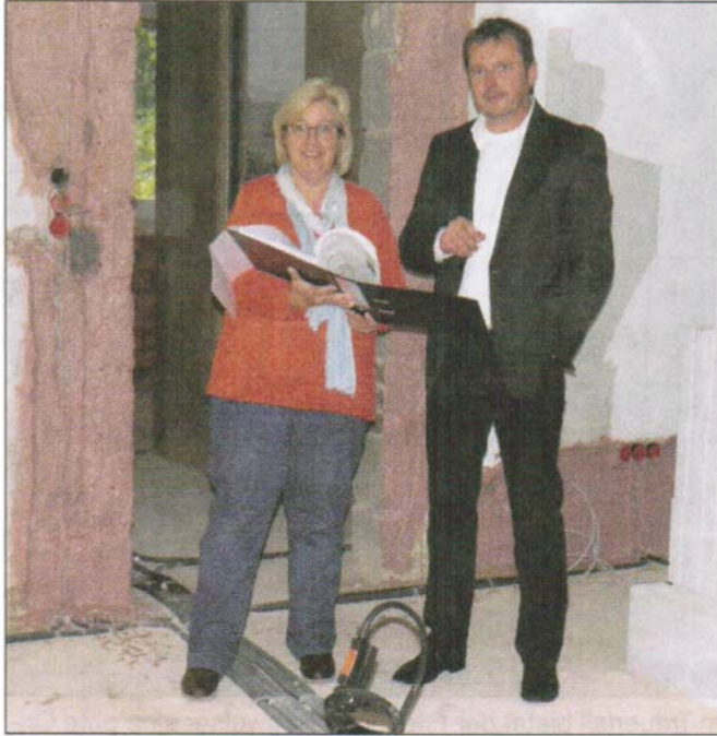
Noch viereinhalb Monate eine Baustelle.
